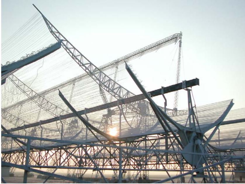
Figura 1.3 Particolare dell'antenna Croce del Nord (sono visibili i fili metallici)
